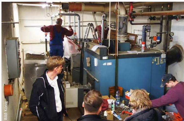
**Heizzentrale aus dem Jahr 1969 mit Ölkessel vorne und Spitzenlast-Gaskessel hinten. Umstellung auf Holzpellets und Erneuerung von Nahwärmenetz und Heizzentrale im April 2016**
