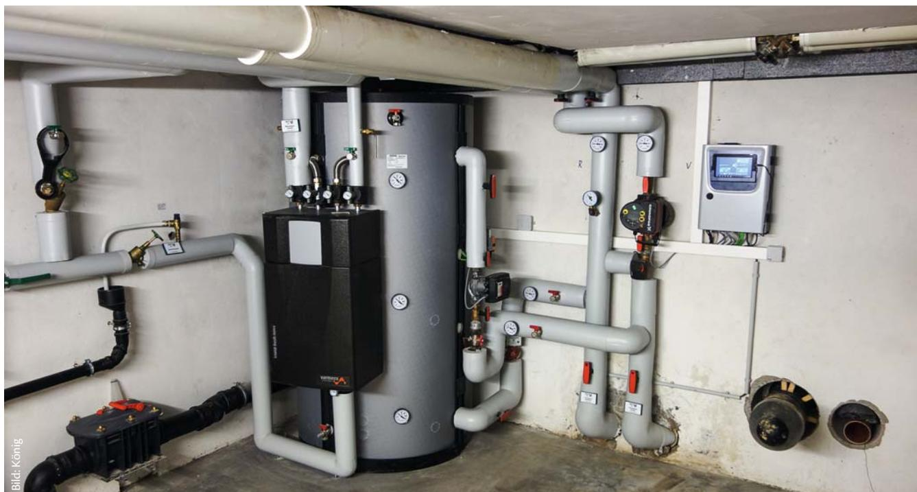
**Unterverteilung der Heizung mit Warmwasser-Pufferspeicher im bereits sanierten Gebäude kurz vor der Umschaltung**
