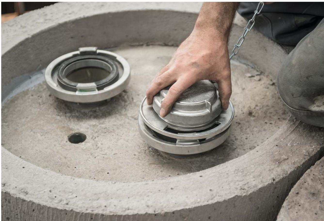
**Eine der drei Befüllöffnungen des Pelletspeichers im Außenbereich. Durch Befüllen an drei verschiedenen Stellen lässt sich im Speicher mehr Nutzvolumen erzielen, da kleinere Schüttkegel als bei nur einer Öffnung entstehen**
