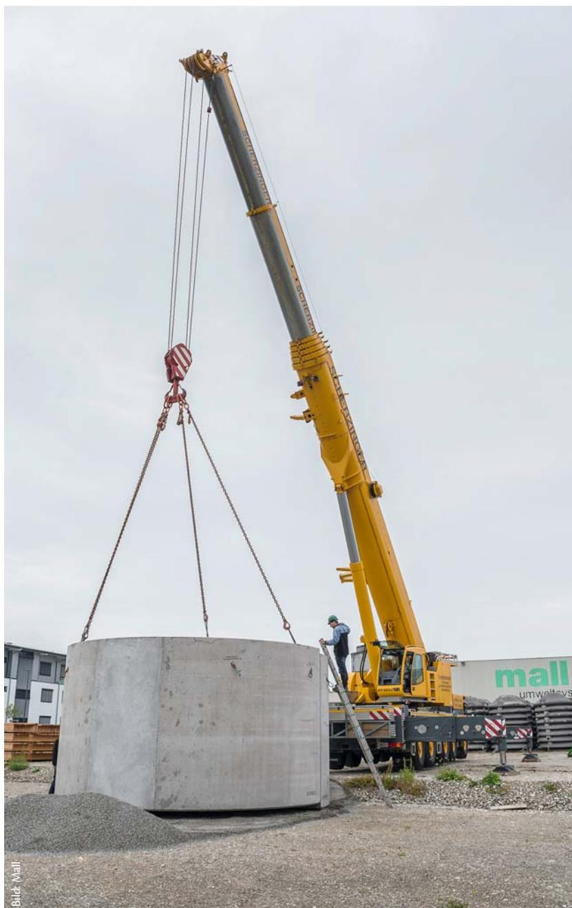
**Verladen des Pelletspeichers in Einzelteilen auf Lkw beim Hersteller Mall in Donaueschingen-Pföhren**
