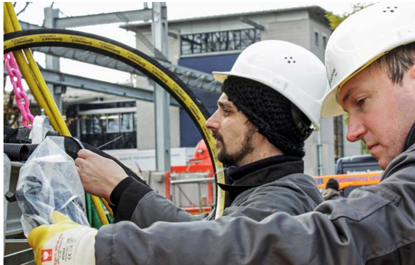
Der hohe Außendruck von 10 bar in einer Wassertiefe von 100 m macht dem robusten, trinkwassertauglichen Schlauch nichts aus
