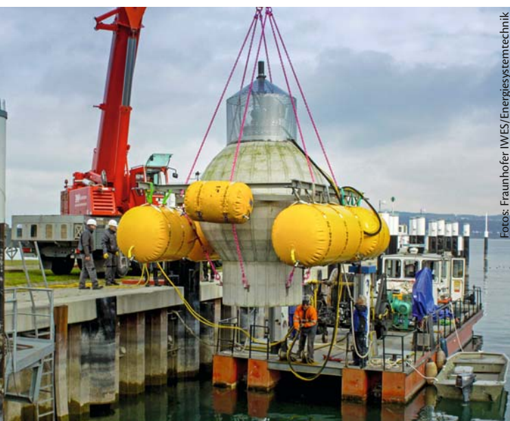
Die 20 Tonnen schwere Hohlkugel wurde als Modellversuch im Bodensee versenkt
