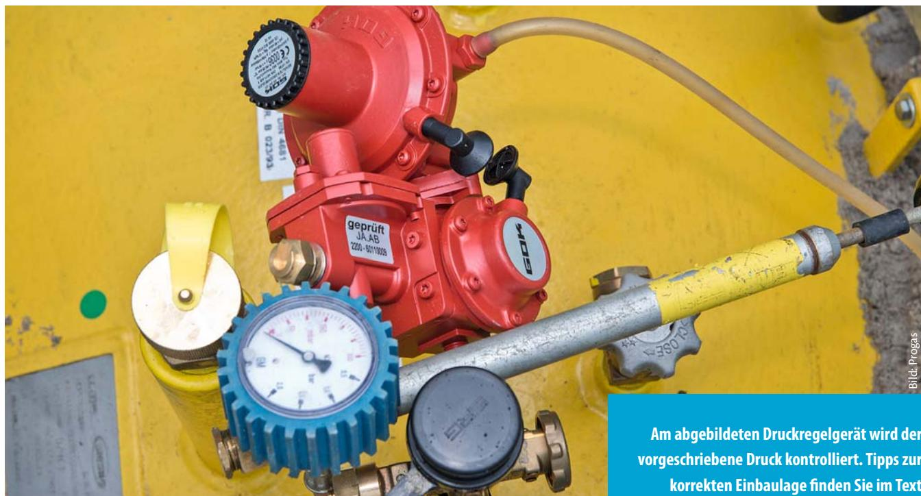
Am abgebildeten Druckregelgerät wird der vorgeschriebene Druck kontrolliert. Tipps zur korrekten Einbaulage finden Sie im Text
