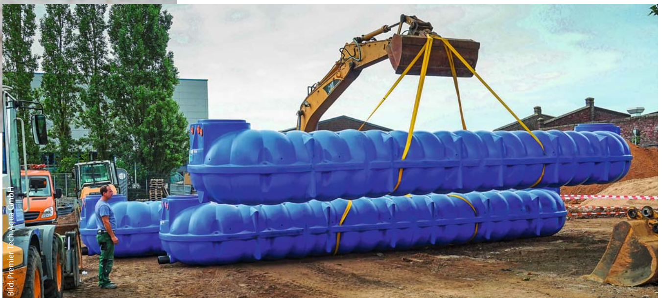
Flachtanks, wie hier vom Typ Neoplus, können anfallendes Regenwasser verzögert an die Kanalisation abgeben
