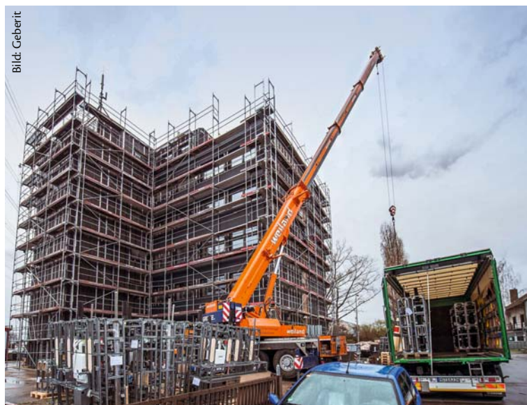
Mit einem Kran wurden die Geberit-Sanitärwände in das Monteurhotel gehoben
