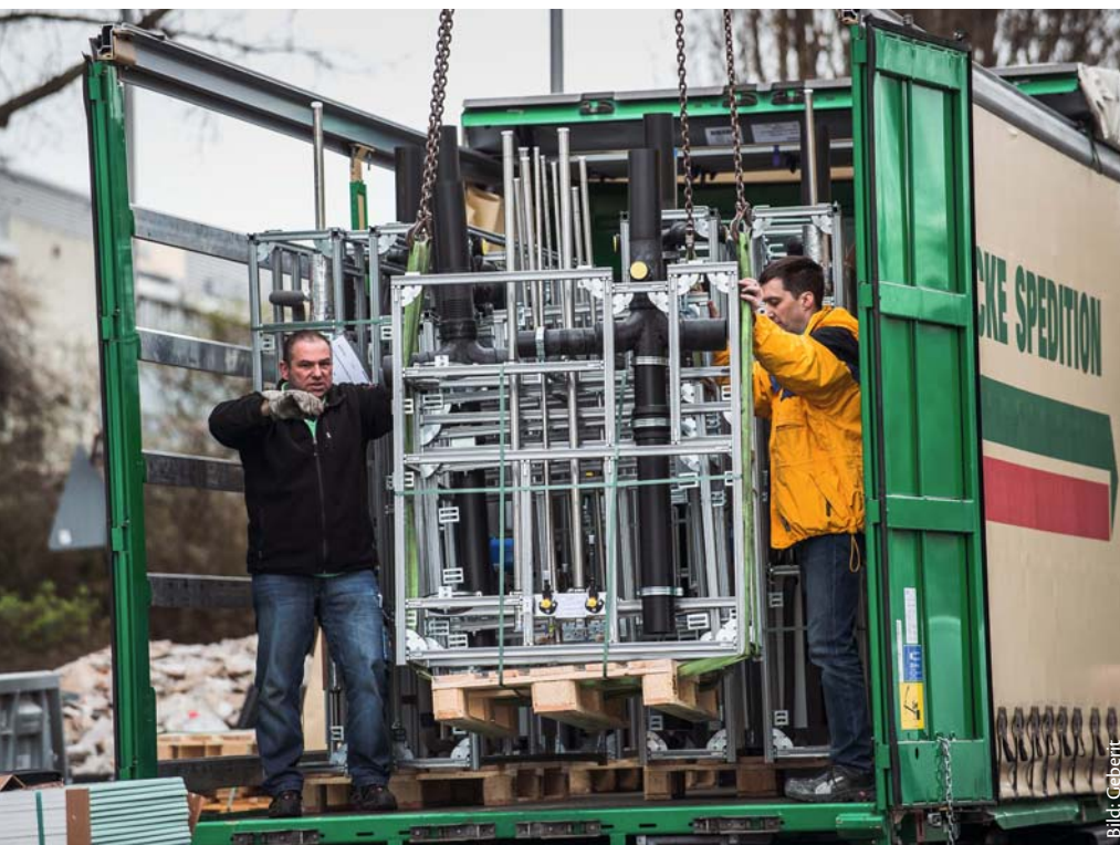
So wurden die industriell vorgefertigten Sanitärwände für die 85 Hotelbäder an zwei Liefertagen per Lkw auf die Baustelle geliefert
