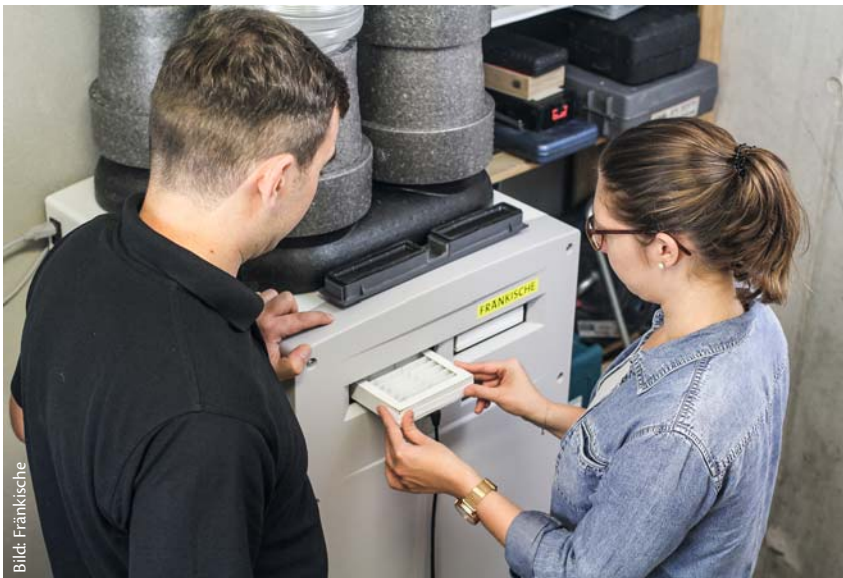
Der Kunde lernt bei der fachgerechten Inbetriebnahme einer Kontrollierten Wohnraumlüftung unter anderem den periodisch angezeigten Filterwechsel am Lüftungsgerät kennen
