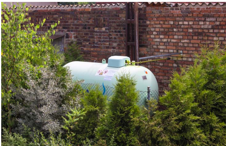
Hier wurde werkseitig isoliertes Kupferrohr (WICU) in Stangenform verwendet und über eine Halterung zum Mauerwerk geführt
