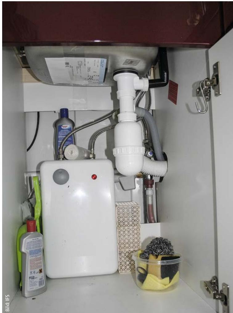
**Unverdächtig: Das „gute, alte“ drucklose Untertischgerät ist immer noch ein funktions sicherer Klassiker, wenn es korrekt montiert wird**
