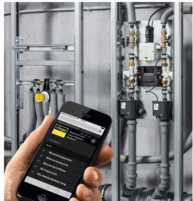
**Im erweiterten „Advanced“-Modus ist die Inbetriebnahme per WLAN über eine Vielzahl von Endgeräten, beispielsweise einen Tablet-PC oder ein Smartphone möglich.**
