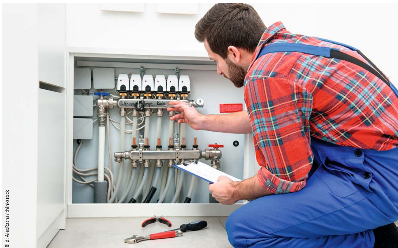
Der hydraulische Abgleich der fast fertigen Anlage gehört zum Gesamtkunstwerk einer Flächenheizung
