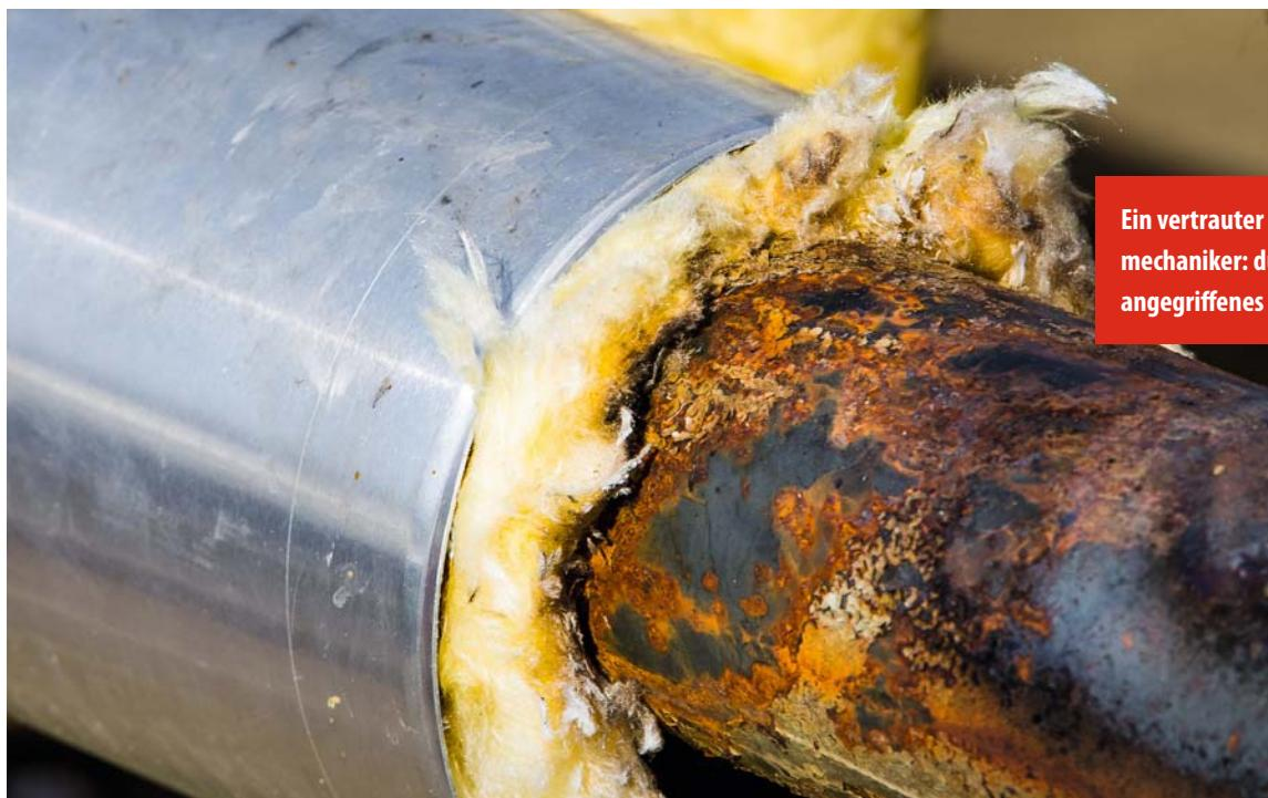
Ein vertrauter Anblick für Anlagenmechaniker: durch Korrosion angegriffenes Stahlrohr
