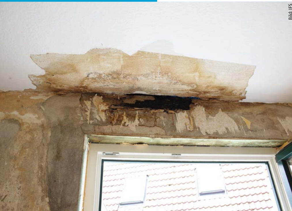
Bild 1: Die Bausubstanz oberhalb des Fensters ist stark geschädigt
