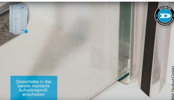
**1.) Das Glas wird in den Träger eingeschoben. Der Vorgang wird durch eine Führung im Profil zusätzlich unterstützt, sodass keine Kratzer entstehen können**
