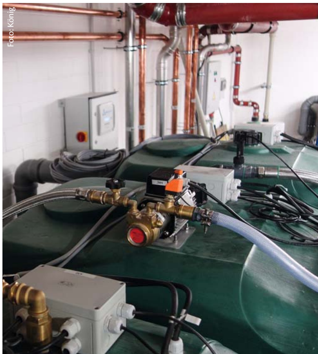
PowerClear MC 5000 Grauwasseranlage mit 3 Tanks à 3000 Liter, zur Aufstellung innerhalb von Gebäuden. Kapazität: Bereitstellung von 5000 Litern Betriebswasser pro Tag
