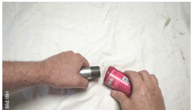
Der bereits aufgeraute Nippel kann auch mit Teflon-Band zur dichten Gewindeverbindung vorbereitet werden
