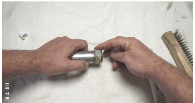
Finale beim Umgang mit Hanf: Mit einer Dichtpaste wird das Gewinde endgültig zum Einschrauben vorbereitet
