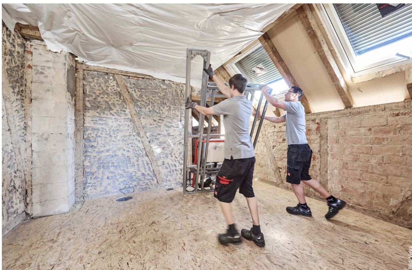
Die in der Werkstatt vorgefertigten Elemente, hier ein Raumteiler als raumhohe Schamwand zum WC, sind in Minutenschnelle aufgerichtet.
