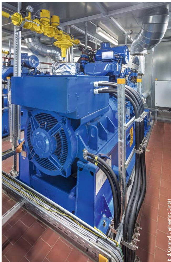
Zwei BHKWs decken die gesamte Grundlast des Klinikums ab und bilden das neue Herz der Energiezentrale im denkmalgeschützten Kesselhaus.
