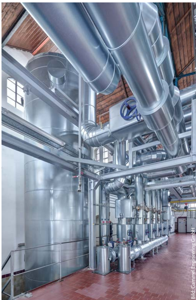
So schön kann Heiztechnik sein: Der Pufferspeicher mit 50 m 3 Fassungsvermögen
