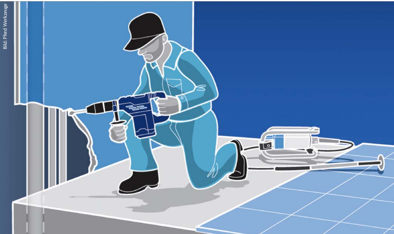
1.) Aufstemmen der Wand in der Baustelle. Im Geschoss darunter werden keine Arbeiten durchgeführt.
