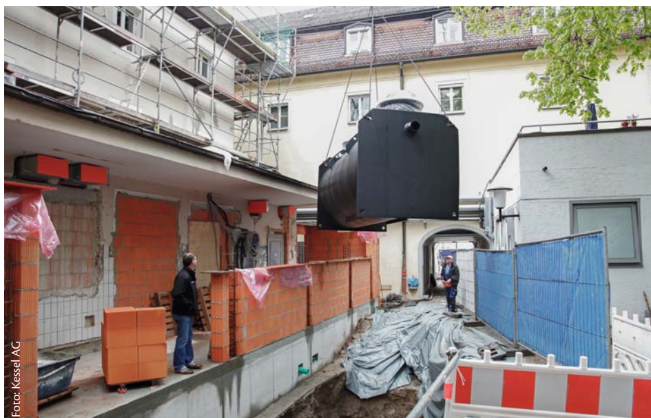
Erdeinbau eines Fettabscheiders, mit der Unterstützung eines Krans
