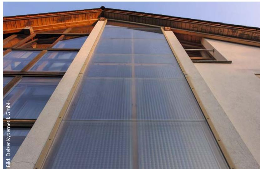
**Die senkrecht in die Fassade integrierte Solaranlage liegt immer frei und hat im Winter einen rund doppelten Ertrag im Vergleich zu leicht geneigten Anlagen**
