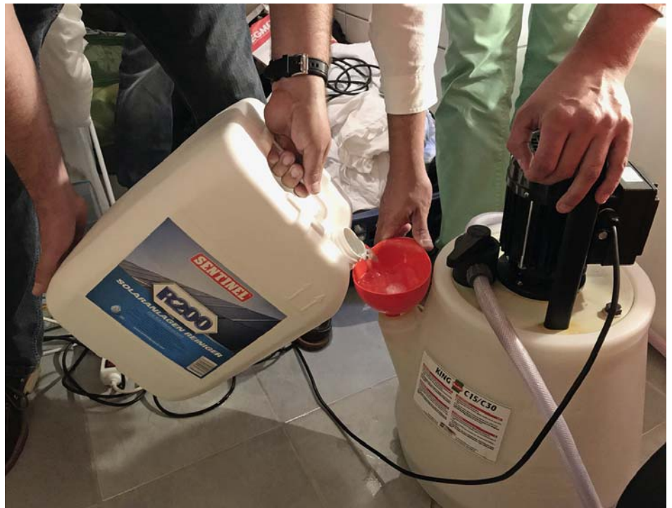
Befüllung des Spülgerätes während der Wartung
