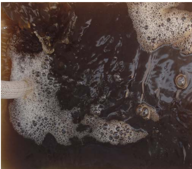
Während des Ablassens der alten, degradierten Wärmeträgerflüssigkeit
