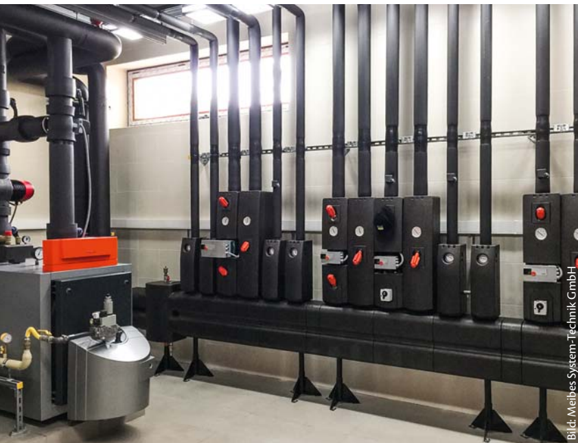
Aufbau eines Verteilers mit vorgefertigter Dämmung
