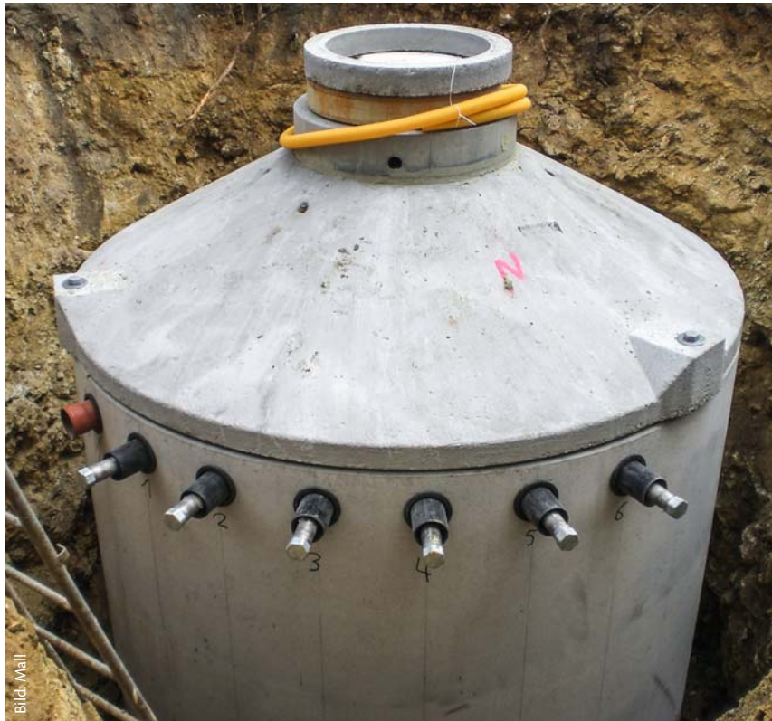
Pufferspeicher ThermoSol mit werkseitig eingebauten Edelstahlrohren für den Anschluss der unterirdischen Verbindungsleitungen zum Gebäude
