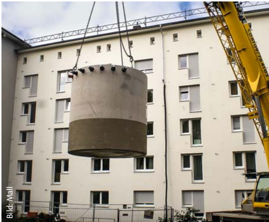
Einer der beiden Pufferspeicher ThermoSol beim Versetzen in der Homburger Landstraße in Frankfurt
