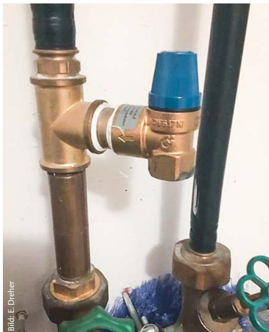
**Ein Beispiel für die Arbeit eines Unwissenden an einem Sicherheitsventil: Die Hygiene des Trinkwassers wird zwar nicht beeinträchtigt, aber die Anlage kann die sprichwörtlich dicken Backen kriegen. Das SV kann so nicht öffnen**
