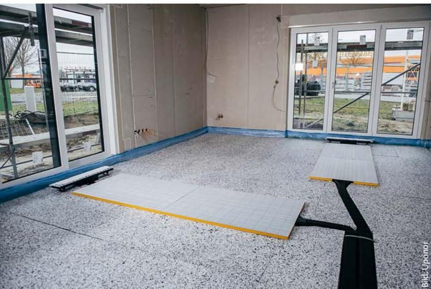
**Die Bodenpaneele werden unmittelbar vor den Luftauslässen installiert und lassen sich für einen höheren Komfort in Reihe schalten**
