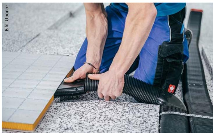
**Mithilfe steckbarer Kanalübergänge wurden die Panels mit den tiefer liegenden Lüftungskanälen verbunden**
