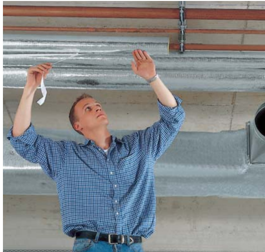
Montage der Rockwool 800 an Heizungs- und Trinkwasserleitungen
