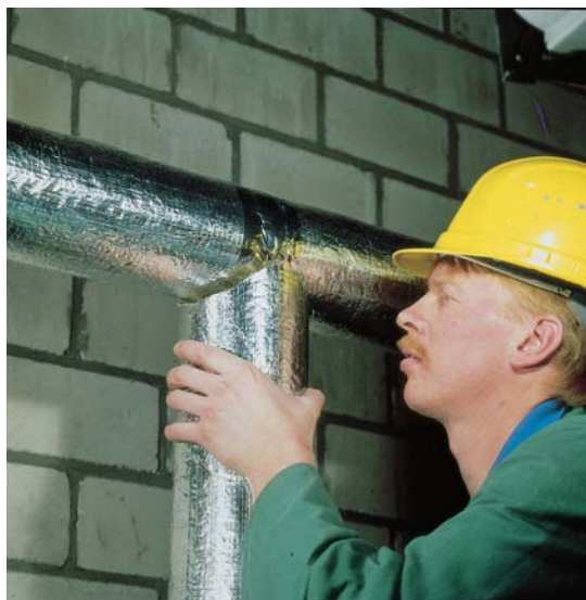
Montage der Dämmschale Rockwool 800 an T-Stücken
