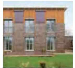
Abb. B.1.6–14 Fassadenmontage, senkrechte Flächen
