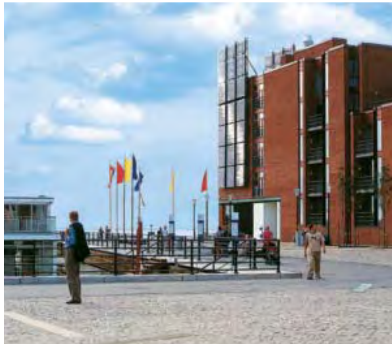
Abb. B.1.7-1 Kollektorfassade in der „City of tomorrow“.
