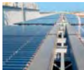
Abb. B.1.6–12 Flachdachmontage (liegend)
