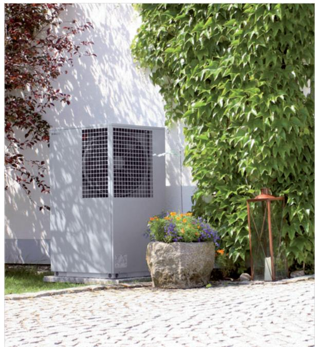
Abb. 5.3: Luft/Wasser-Wärmepumpe in Außenaufstellung
