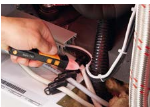
Erstprüfung der Spannungsversorgung an einem Verdichter.
