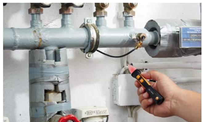
Spannungsüberprüfung an einer Verteilerdose mit testo 745 .
