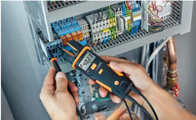
Spannungsprüfung an einer Wärmepumpe mit testo 755 .
